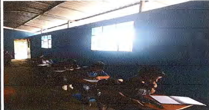
Foto 2: Pared mejorada satisfactoriamente.
