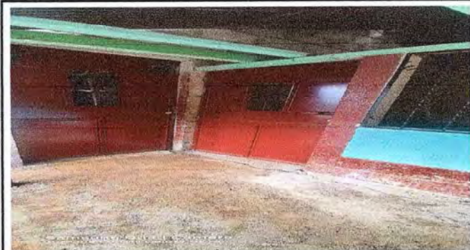
Foto 4: Se sustituyeron las puertas de madera por puertas de metal.
