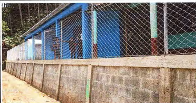
Foto 1: Muro perimetral mejorada satisfactoriamente.
