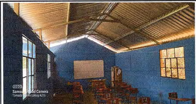
Foto 3: La sustitución y el mejoramiento del entechado.
