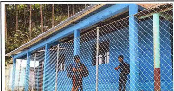
Foto 5: En la Imagen se observa las ventanas nuevas.
